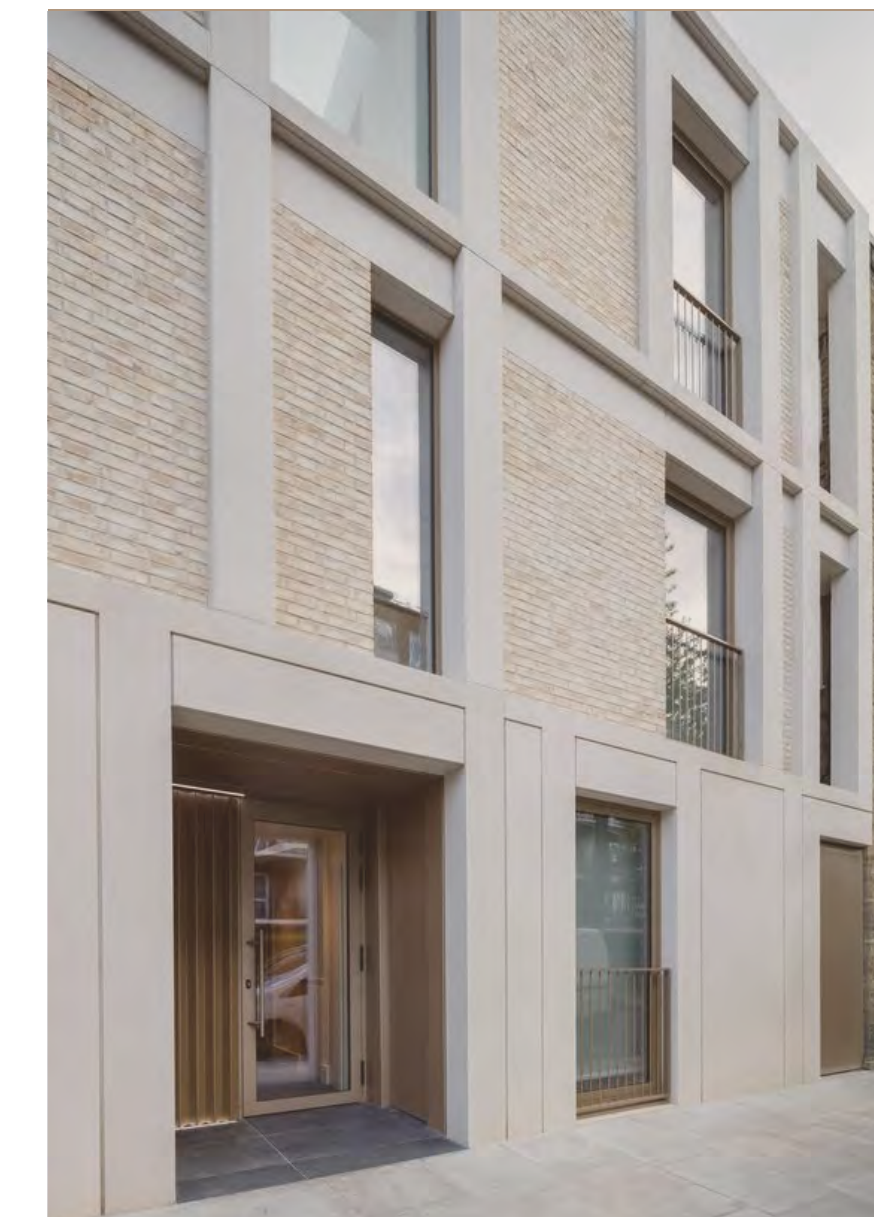
Prefab beton grijs / zandkleurig, licht aangestraald en gehydrofobeerd.
