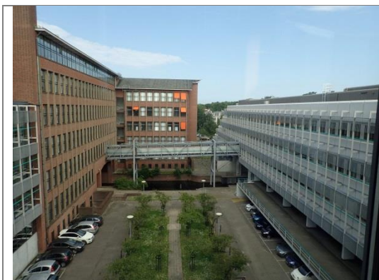
Foto 3: De binnenplaats, met links de stenen bouwdelen langs de Plesmanweg en rechts bouwdelen met metalen panelen en de parkeergarage.
