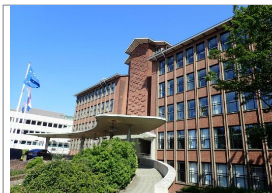
Foto 1: De hoofdingang, met stenen buitengevel. Links is een bouwdeel met metalen gevelpanelen zichtbaar.
