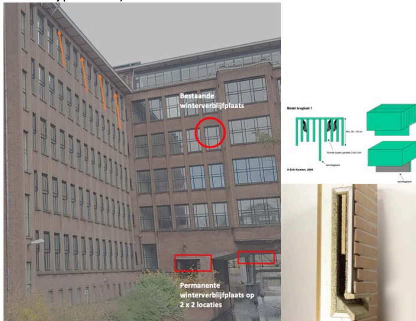
Afbeelding 21. Bestaande en nieuwe massawinterverblijfplaats (de oranje pijlen geven de 4 nieuwe permanente kraamverblijfplaatsen aan)
