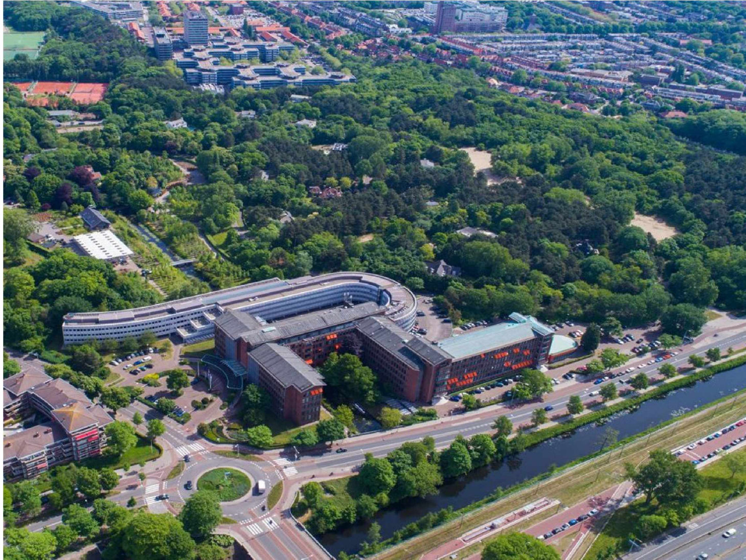
Plesmanduin is gelegen in één van de grote groengebieden die karakteristiek zijn voor dit deel van de stad Den Haag. Wat het gebied extra interessant maakt is het feit dat verwijst naar het oorspronkelijke (duin)landschap waarop de stad is gesitueerd. Met name het naast project gelegen Hubertusduin is met zijn grote hoogte en karakteristieke beplanting een bijzonder landschappelijk element.
